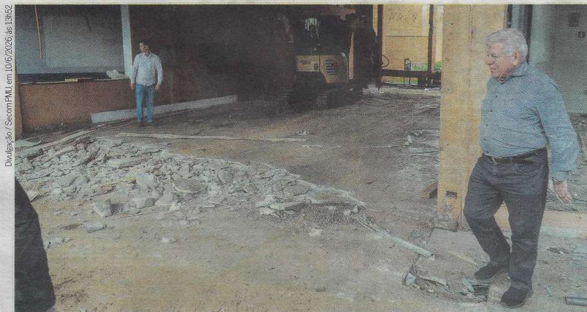
Prefeito Scanavaca conferindo pessoalmente o início das obras na antiga rodoviária
