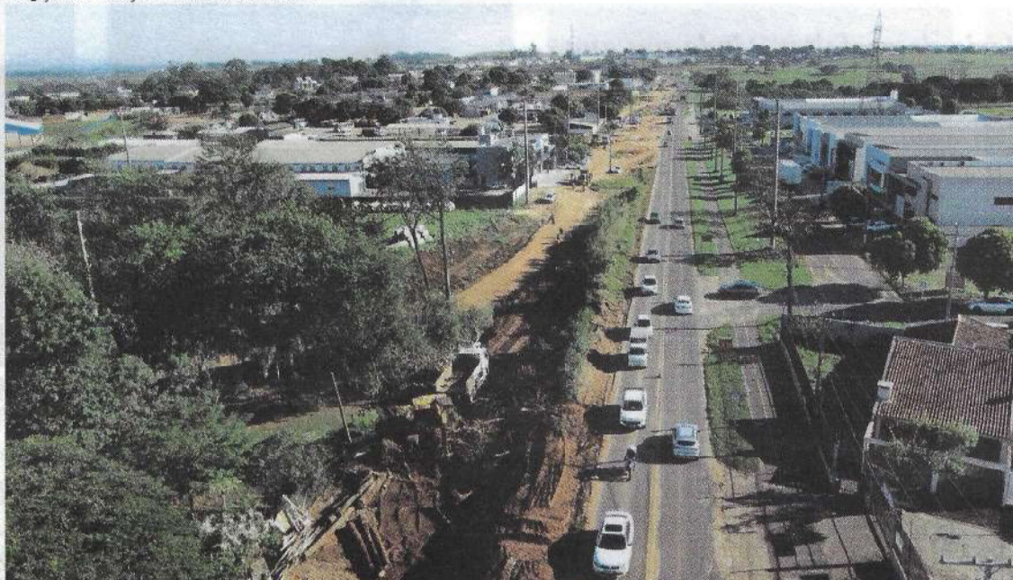
Rodovia PR-580 dá lugar à avenida Pedromiro. Trecho de dois quilômetros está sendo duplicado: grande conquista à Umuarama e Região Metropolitana.
