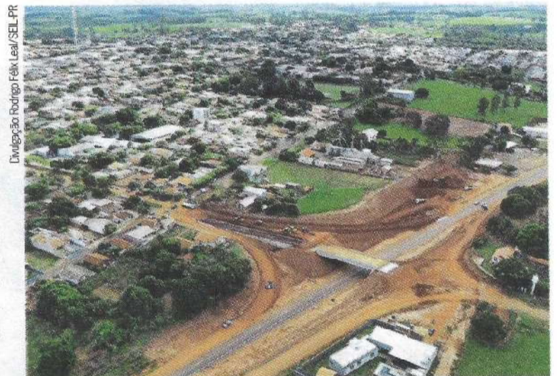
Viaduto de Iporã está com as obras quase prontas
